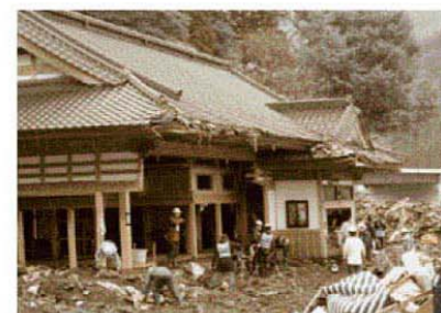
被災した神社のがれき撤去と泥出しの様子
