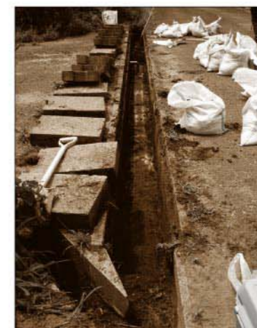
作業後の側溝
